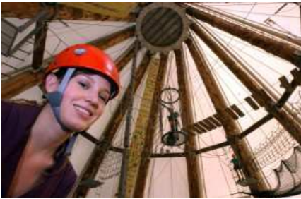
Der beliebte Hochseilgarten im Big Tipi ist schon seit rund zwei Jahren wegen Baufähigkeit gesperrt. Die Sanierungskosten sind zu hoch. Archivbild: Alex Völkel
